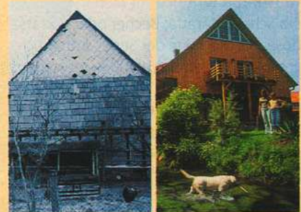
Gelungene Sanierung: vom abbruchreifen Haus zum Schmuckstück
